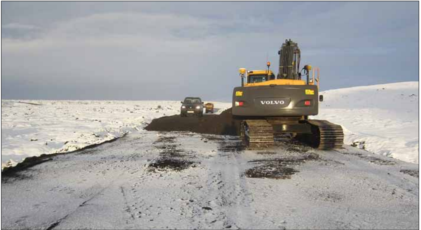
Hafin er vinna við breikkun Hringvegur (1) um Hellisheiði. Innifalið í því verki er gerð 1,8 km vegar frá Hamragilsvegi að skíðaskálanum í Hveradölum en sú framkvæmd er til að fækka vegamótum við Hringveg. Myndin hér að ofan sýnir vinnu við þann veg. Verktaki er Ístak hf.
